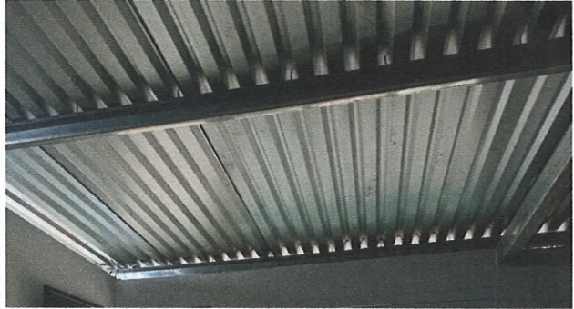
Foto 2: Mejoramiento de modulos con estructuras y techo troquelado
