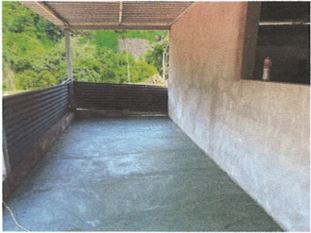
Foto 5: Mejoramiento de corredor modulo del aula
