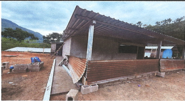
Foto 4: Mejoramiento de modulo
