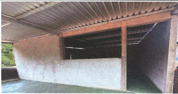
Foto 6: Mejoramiento de ventanas y puertas de modulo
